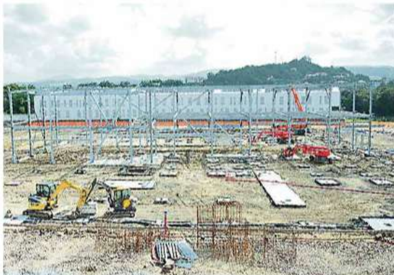
La charpente métallique du foyer est quasiment terminée.
