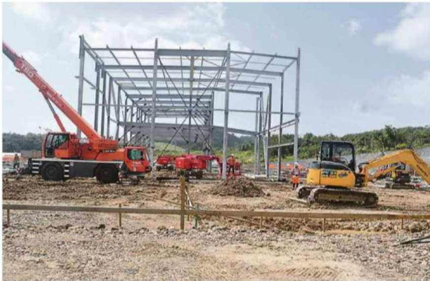
La charpente métallique du foyer est quasiment terminée.
